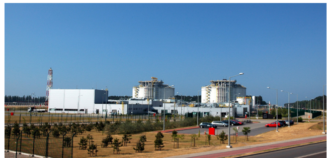
The Świnoujście LNG terminal
